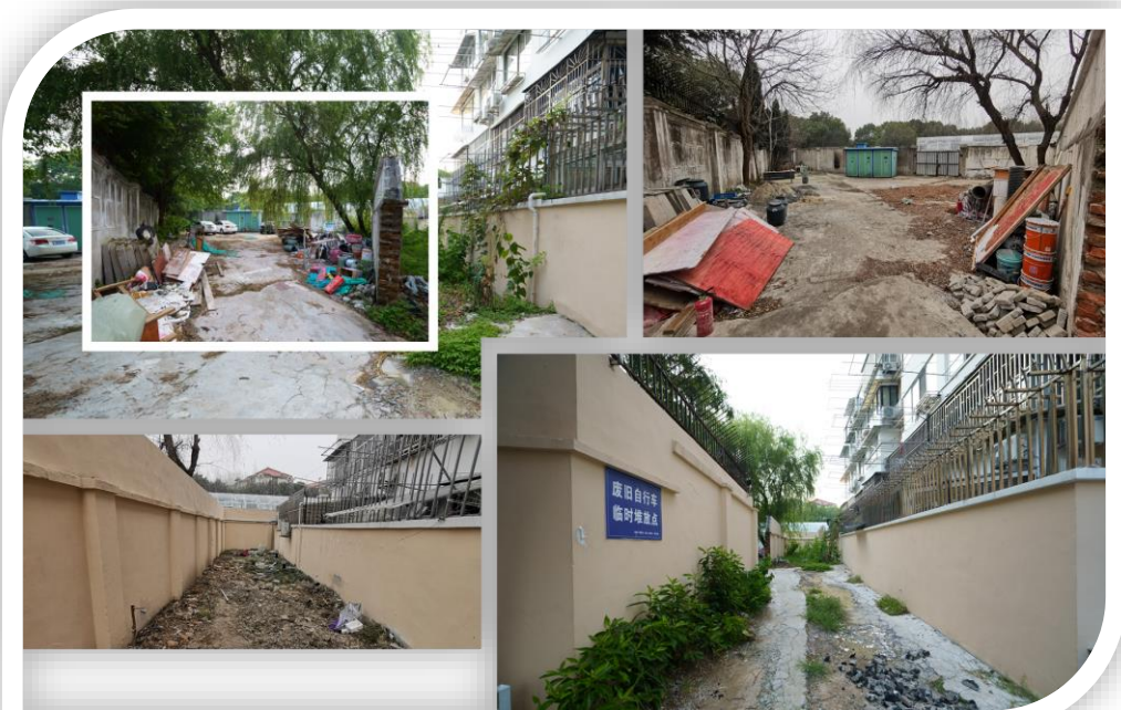
改造前：拆违后闲置空地
